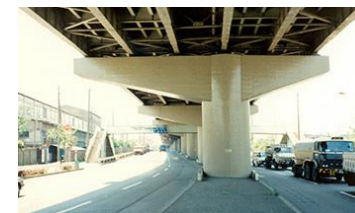
高速道路橋桁
